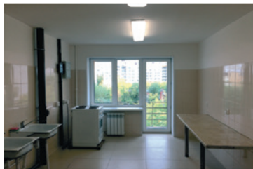
Капитальный ремонт студенческого общежития
