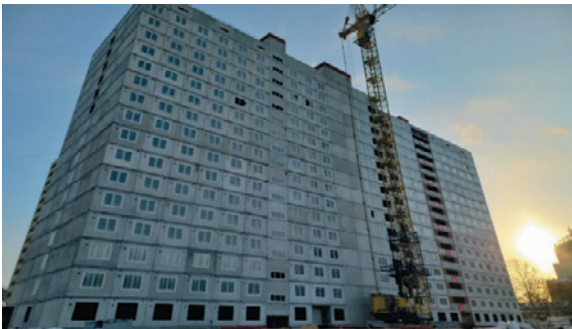
Завершены работы по возведению здания, проводятся работы по устройству внутренних инженерных систем и сетей
