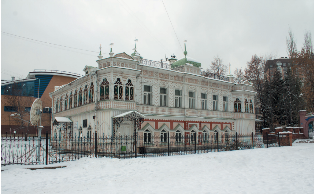
Ил. 4. Особняк, принадлежавший З. Агафурову. Екатеринбург, ул. Сакко и Ванцетти, 2016 г. Постоянное представительство Республики Татарстан на Урале. Фото А. Заболотных
