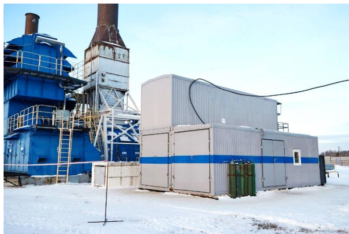
Экспериментальный образец установки утилизации дымовых газов
