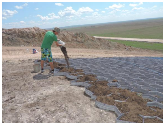
Рисунок 1 – Установка георешетки и заполнение ее ПС
