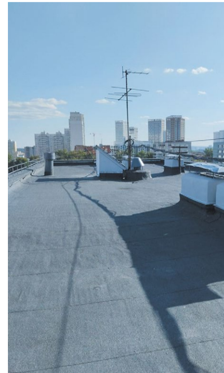
▲ В общежитии № 7 на ул. Коминтерна, 3А провели капитальный ремонт кровли
